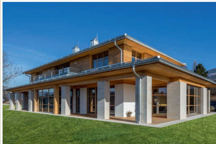
Wohnhaus Familie Kohlbach, Michaelsdorf Vorgemauerte Sandstein-Fassade, 8 cm dick Fa. Lauster Steinbau GmbH
