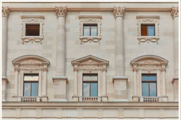
Zweiter Rang: Schreiber und Partner Natursteine GmbH erhielt den Preis dabei für ihre Sanierungsarbeiten an einem südlichen Flügel der Hofburg, dem sogenannten Fassadenabschnitt 3.
