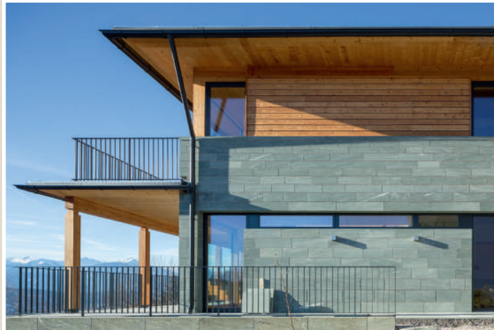
Wohnhaus Familie Lauster, Millstatt Vorgesetzte Gneis-Steinfassade „Dorfergrün“ Fa. Lauster Steinbau GmbH
