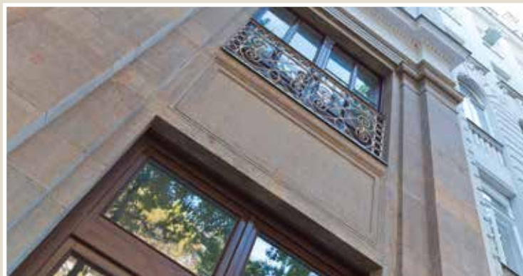
Praterstraße 42: Bei der Sanierung wurden alte Farbreste und Schäden durch frühere Geschäftsinhaber behutsam entfernt. (Foto: Richard Watzke)
