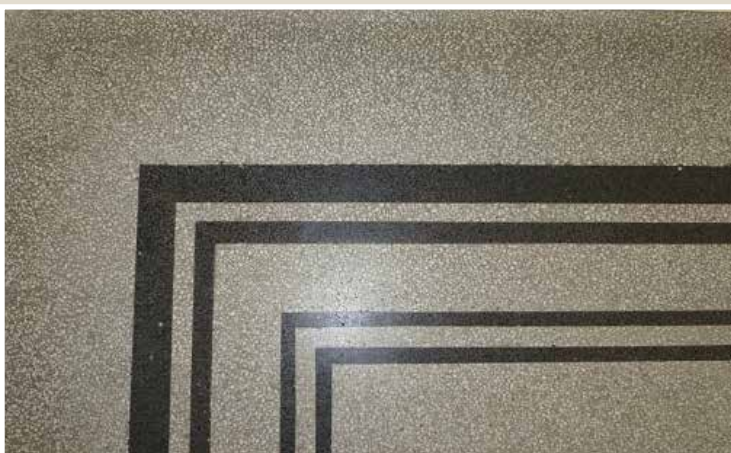
Detail der feinen Terrazzo-Bordüren: Bei der Sanierung wurden die Ornamente in traditioneller Handwerkstechnik ohne chemische Mörtelbeimengungen gefertigt. (Foto: Gabriele Stuhlberger)
