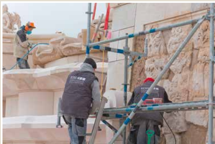
Montage der bekrönenden Apollo-Skulptur: Von dort aus sprudelt seit dem Frühjahr 2018 das Wasser über die Kaskade hinab. (Foto: Richard Watzke)
